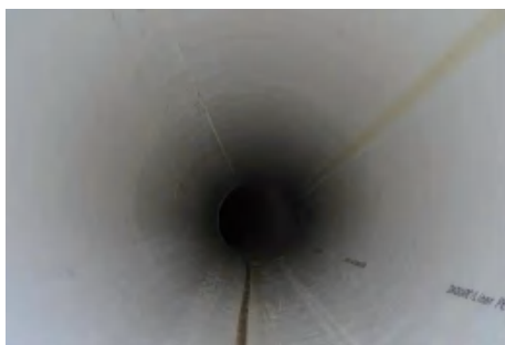
图 15 内衬层树脂材料固化情况
