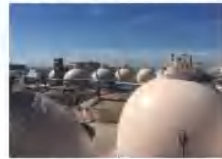
(b) 污泥高温厌氧消化实景
