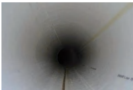
图 15 内衬层树脂材料固化情况
